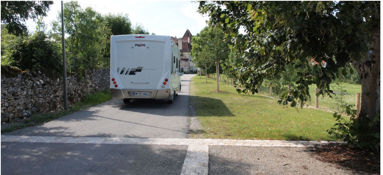
L'aménagement de larges accotements enherbés le long de la traverse participe à réduire la perception de la largeur de la voie et à mettre en valeur le paysage rural alentour. Conception & maîtrise d'oeuvre : G.Laizé Paysagiste-concepteur dplg & A. Marty Architecte dplg - cliché G.Laizé
