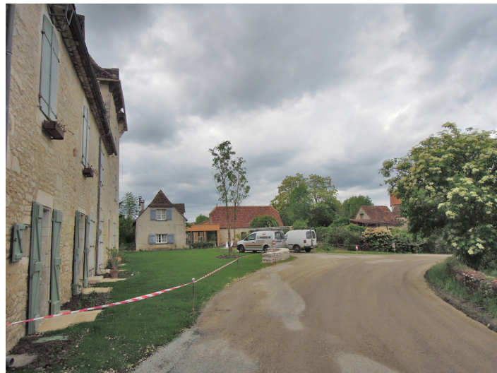
2 - place d'Orniac pendant travaux 2013
