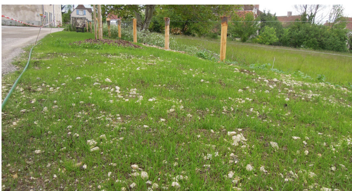
Détail d'un accotement réalisé en grave enherbée ou mélange "terre-pierre"
